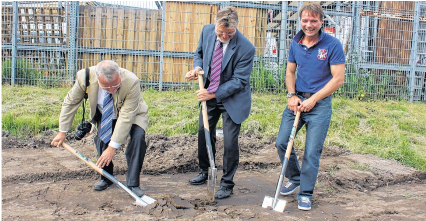
Auch wenn der Bagger schon kräftig buddelt. Auf den offiziellen Spatenstich wollten Architekt Klaus Nissen (von links), Bürgermeister Rainer Dambach und Thorsten Fojtzik von der Firma Plonka als Generalunternehmer nicht verzichten.
